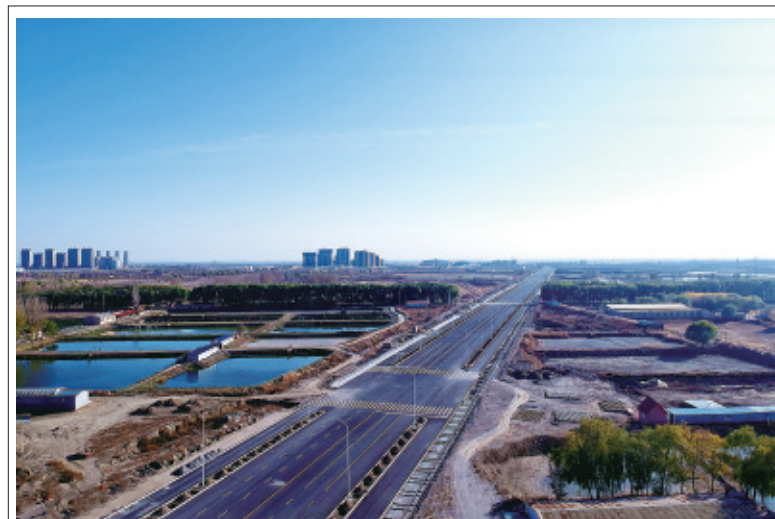
近日,一航局承建的包头市首条南北向“大通道”——沼南大道道路工程主路全线贯通。该工程全长6.7公里,采用双向六车道标准设计。张慧芳 王建华 摄影报道
