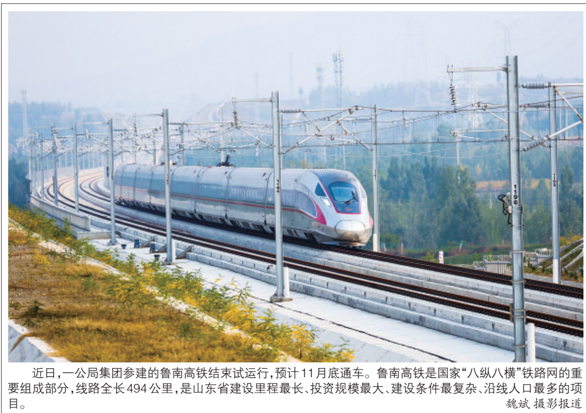
近日,一公局集团参建的鲁南高铁结束试运行,预计11月底通车。鲁南高铁是国家“八纵八横”铁路网的重要组成部分,线路全长494公里,是山东省建设里程最长、投资规模最大、建设条件最复杂、沿线人口最多的项目。魏斌 摄影报道
